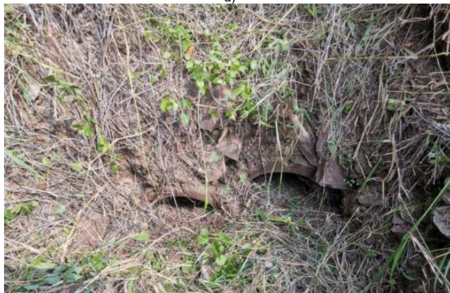
Figura 44 – Passagens hidráulicas bloqueadas/ colmatadas: com balastro, próximo ao Rio Chuquela (k83+591) (a); com detritos, próximo da localidade de Chanculo (k80+968) (b)
